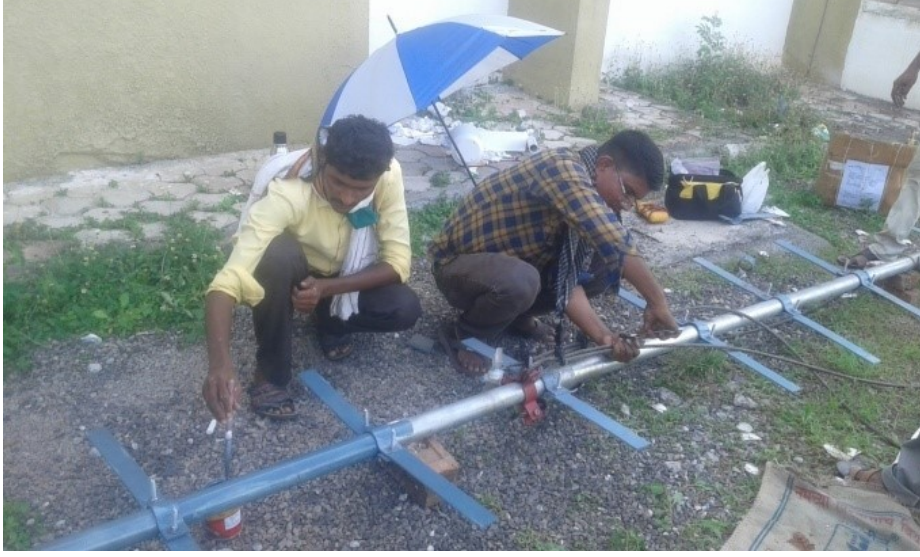
चित्र: मास्ट पर डेटा लॉगर तथा अन्य सेंसर स्थापित करने से पहले पेंटिंग कार्य
